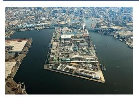
大浜埠頭は、昭和49年に全ての係留施設が供用開始され、水深10m岸壁から、小型船舶を対象とした物揚場まで施設が整備されています。また、埠頭の先端には、西日本最大の青果物取扱能力を有する堺青果センターがあり、南アフリカやイスラエルから冷蔵船で輸入する柑橘類等を揚陸しています。
