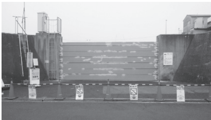
仮設の手動陸閘
