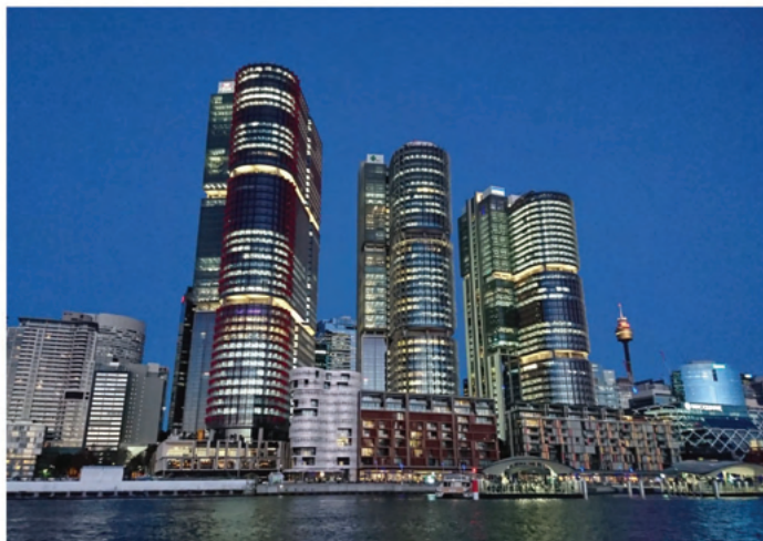
船上から望むバランガルー地区のビル群(オーストラリア・シドニー)
