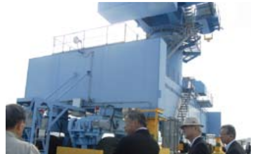
ジブクレーン視察
