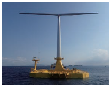
2019年 NEDO 次世代浮体式洋上風力発電システム実証研究 (バージ型)「ひびき」
