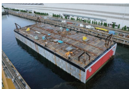
沈埋函の出渠状況
