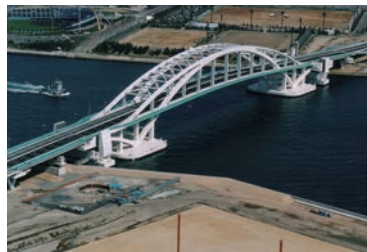
2001年 世界初の浮体式旋回可動橋「夢舞大橋」
