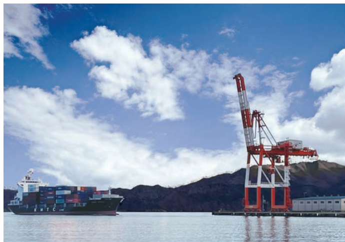
東日本大震災の復興支援として大阪府から釜石港へ 無償譲渡されたガントリークレーン
