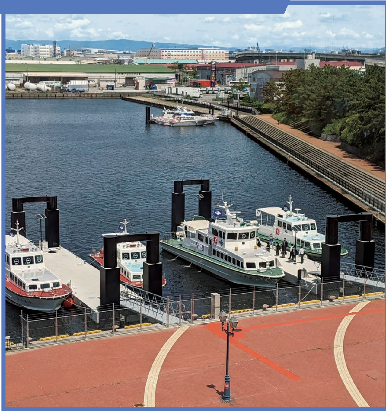
新設の浮桟橋(令和7年4月14日)
