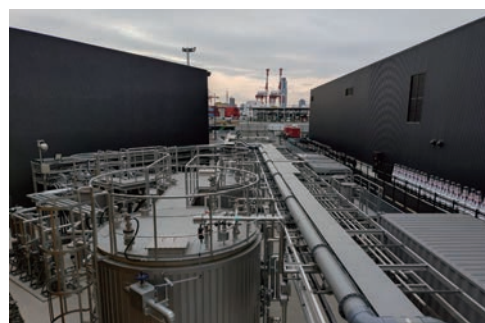
日本館に併設されるバイオガスプラント
