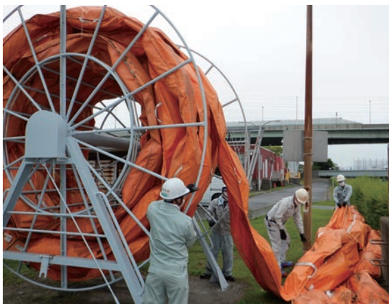
オイルフェンスの点検
