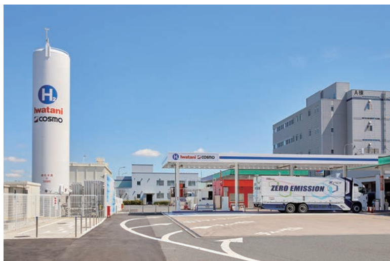
燃料電池大型トラックに対応した「岩谷コスモ水素ステーション平和島」
