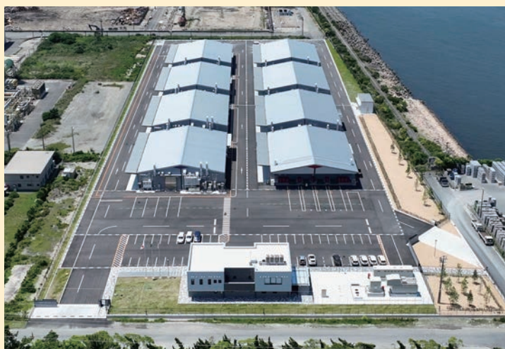
関西ケミカルセンター全景
