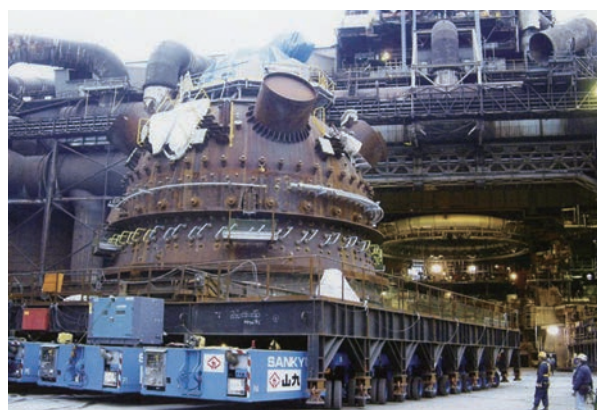
ユニット・ドーリを用いた高炉改修工事
