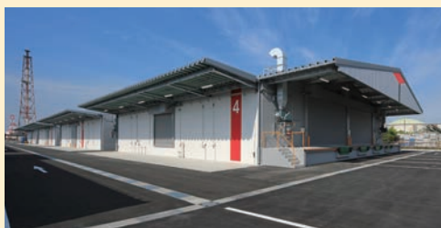
常温・高床式倉庫
