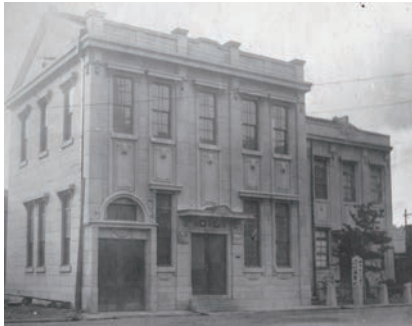
間口組本社建物 1925年頃
