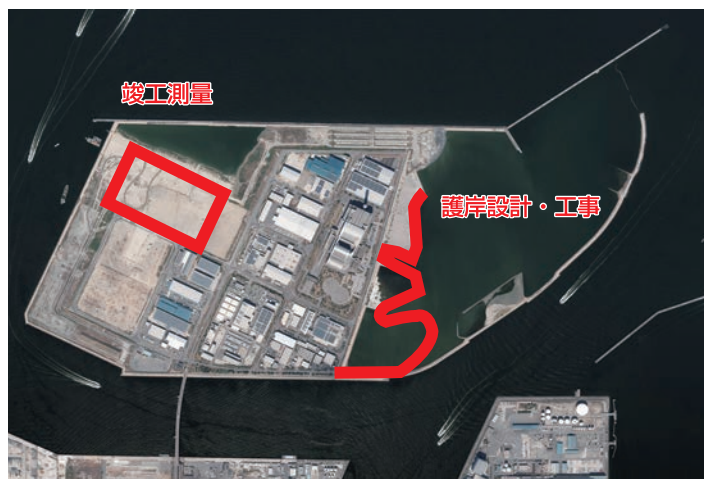
阪南港 阪南2区(ちきりアイランド)
